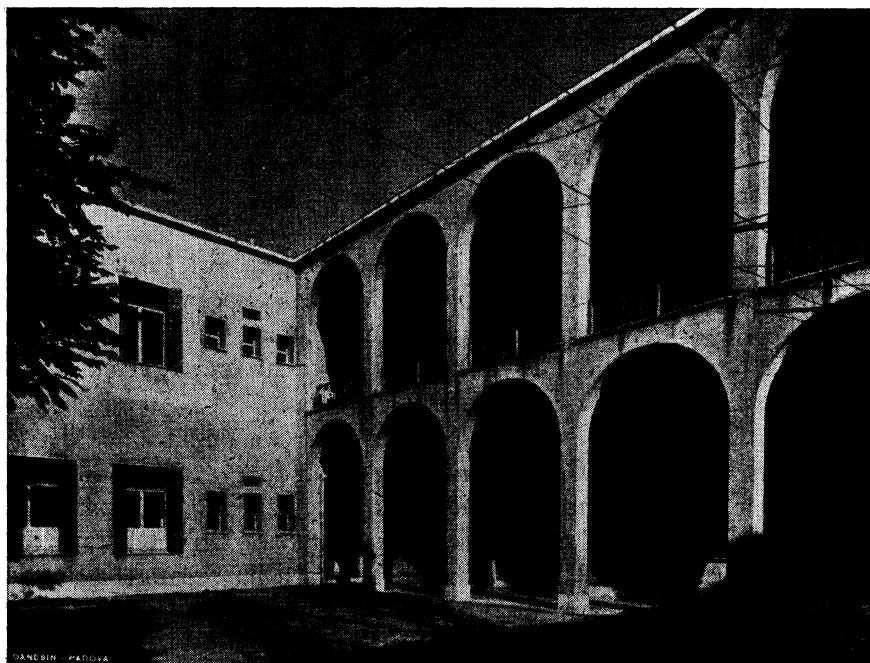
Fig. 1 - Ingresso all'Istituto visto dal cortile
