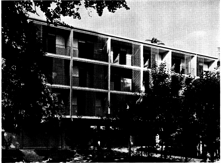
L'ala nuova vista dal giardino
