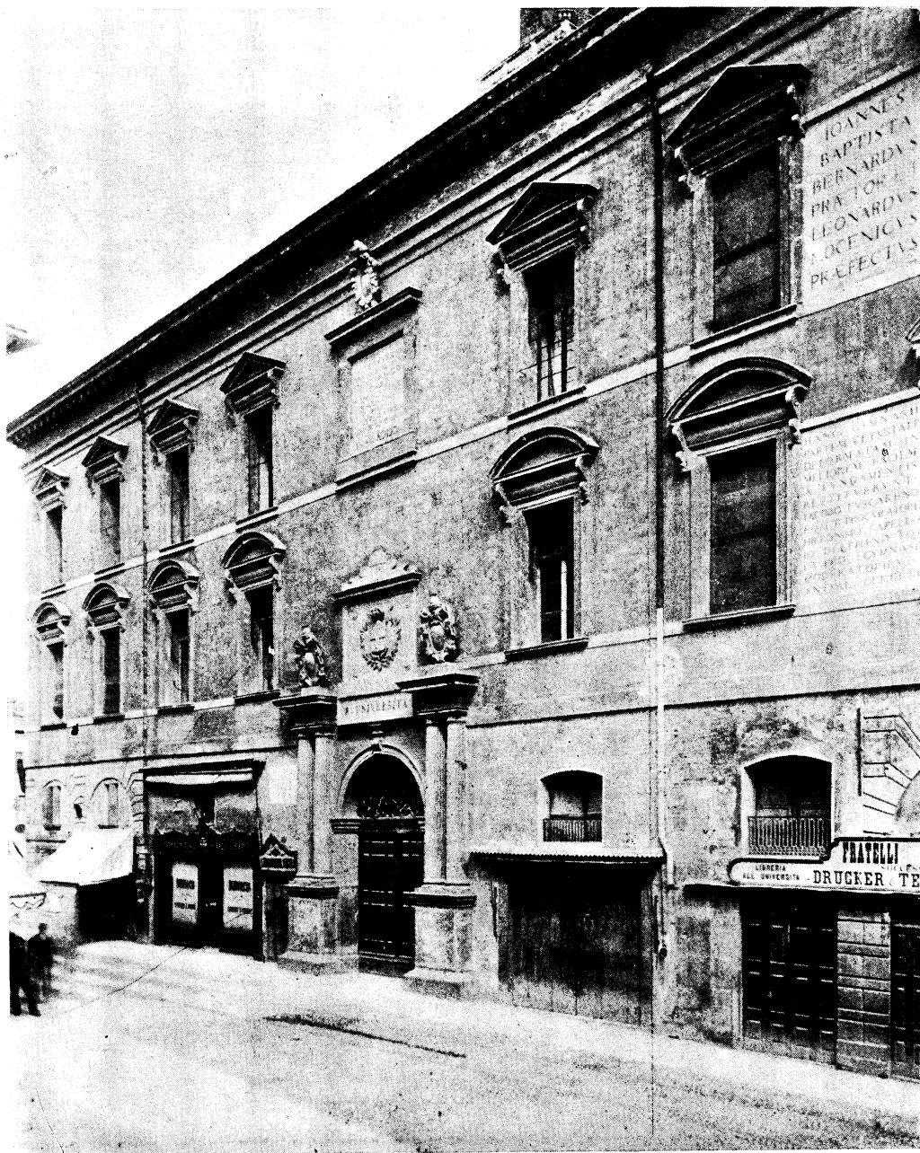
FACCIATA attuale del Palazzo
